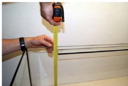
Wurden die genauen Masse ermittelt sollte man noch etwas Luft für die Silikonfuge einplanen. Wir Planen in der Regel 8mm in der Länge und 8mm in der Höhe ein. Was ein Spaltmass von 4mm rund um die Rückwand ergibt.
